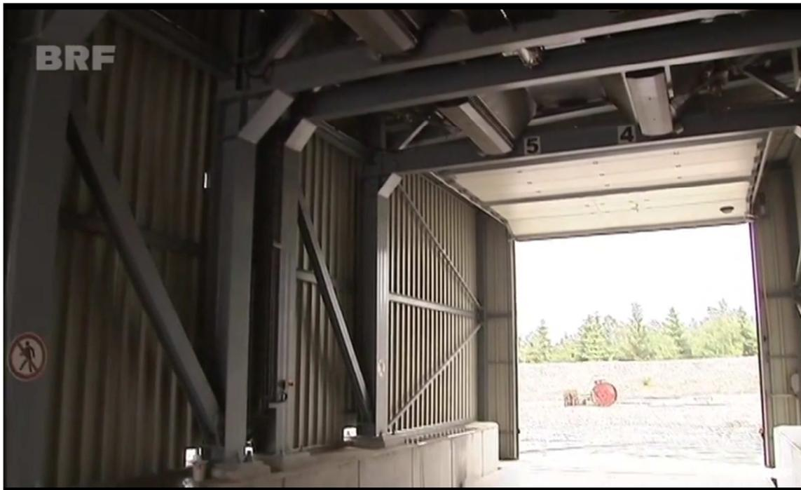
Abb. 13 Vollständige Einhausung und Absaugung des Verladebereichs an einer Asphaltmischanlage mit Trenntürensysteem und eine beidseitig über Rolltore geschlossene Luftscheule im Unterdruckverfahren; Installiert an der Asphaltzentrale Kaiserbaracke / Belgien; Anlagenbau: AMANN in Betrieb gegangen 2015
