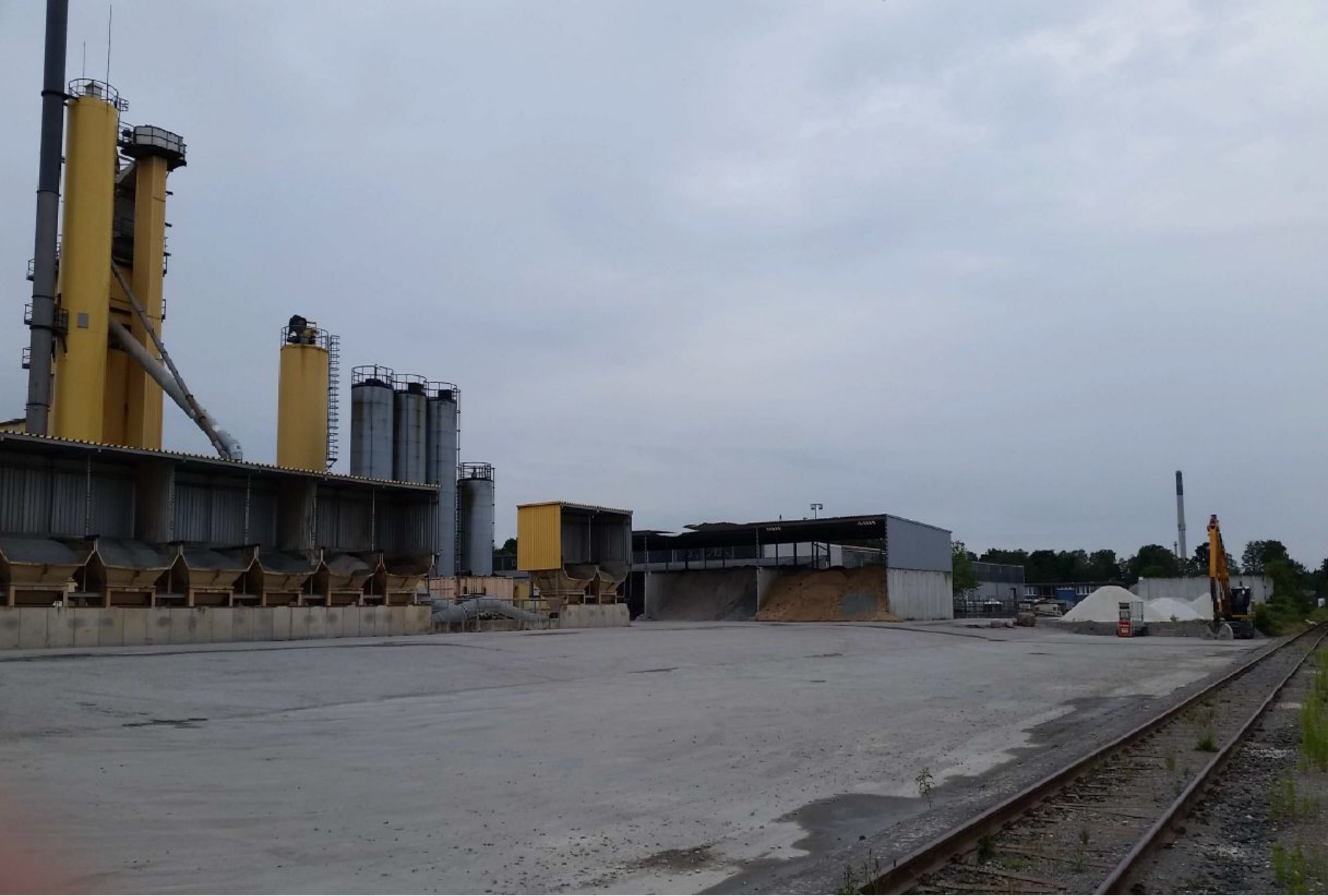
Gelände Asphaltmischwerk Wahlstedt mit Gleisanschluss
